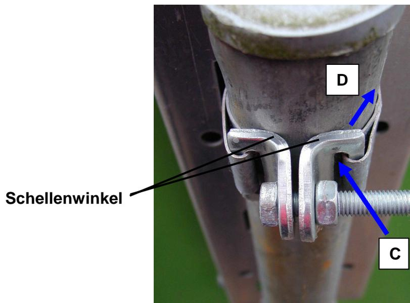
**E:** Über die Schraube/Mutter wird die Schelle jetzt am Pfosten verspannt.
